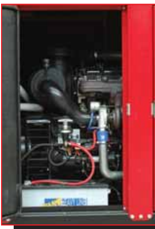
⚠ Battery isolator switch Ⓛ Interrupteur batterie
