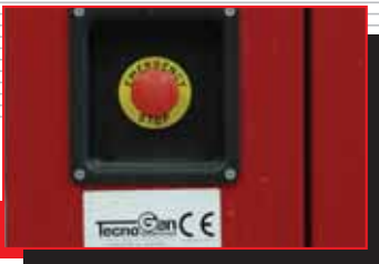
⚠ Emergency stop button placed outside the control panel Ⓛ Bouton d'arrêt d'urgence placé à l'extérieur du coffret
